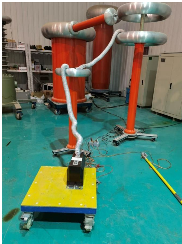
试验照片 Test photo
